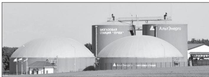
В 2015 году мощность БГС за счет установки третьего двигателя была увеличена до 3,6 МВт. В результате годовой объем электроэнергии повысился до 29,3 млн кВтч, тепловой – до 27,3 тыс.
